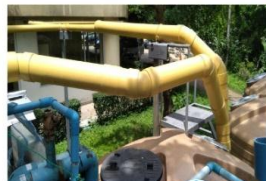
การเดินท่อน้ำเสีย
