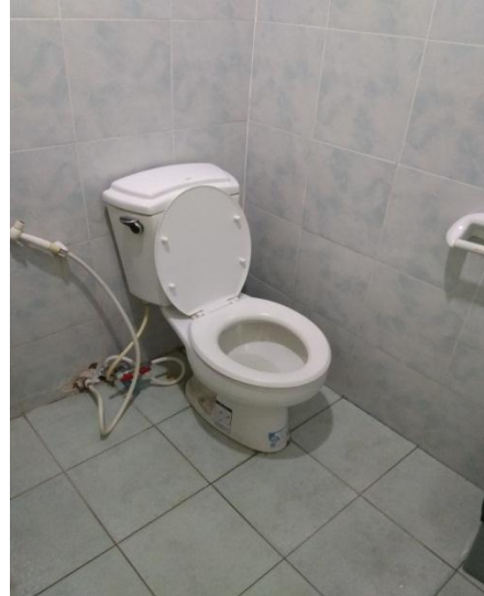
รูปที่ 3.5 การติดตั้งท่อน้ำที่ผ่านการบำบัดเพื่อนำไปใช้ในชักโครก
