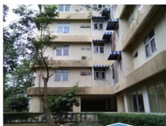
พื้นที่ติดตั้งระบบ
