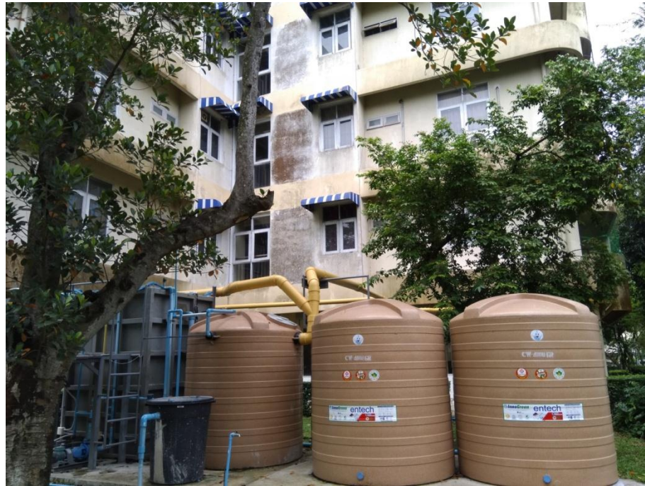
รูปที่ 3.2 การติดตั้งระบบ MBR ที่หอพักบุคลากรกัลยาณมิตร มหาวิทยาลัยศรีนครินทรวิโรฒ (องครักษ์)
